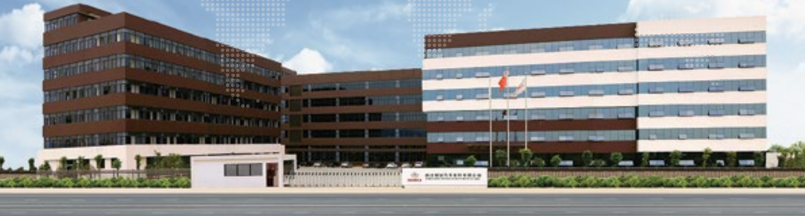
Fábrica de filtros Seineca em Wenzhou, China.
